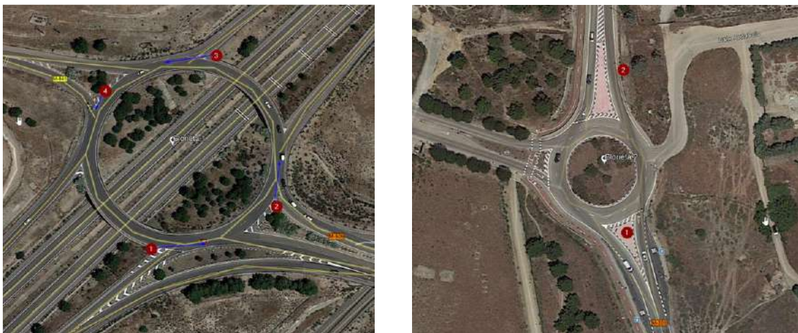
Figura 16. Trabajos de campo. Situación de las cámaras
